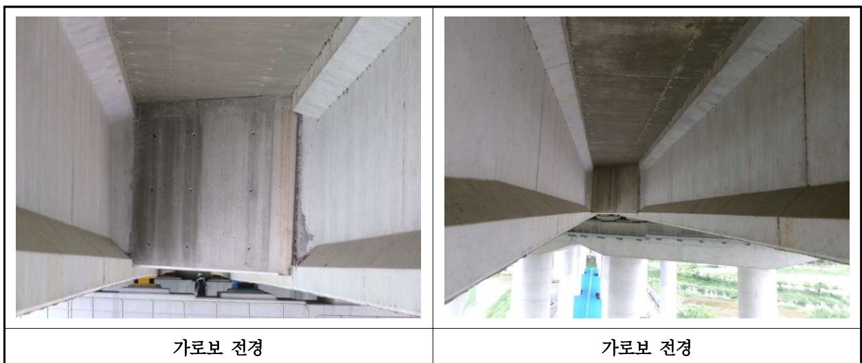
【사진 30.3.6】 가로보 전경
