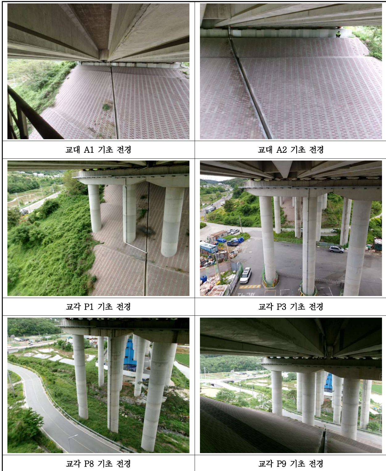
【사진 30.3.12】 기초 전경
