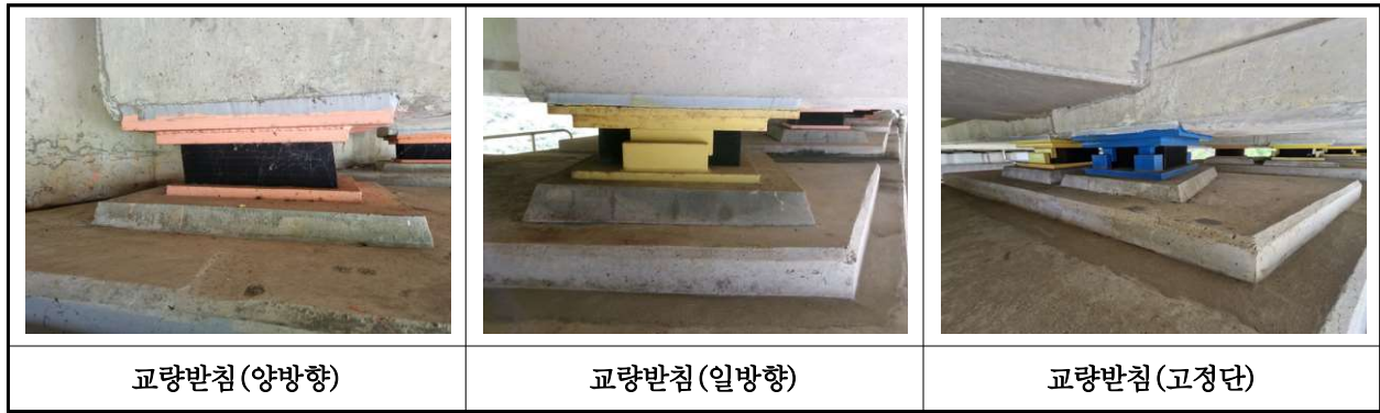
【사진 30.3.13】 교량받침 전경
