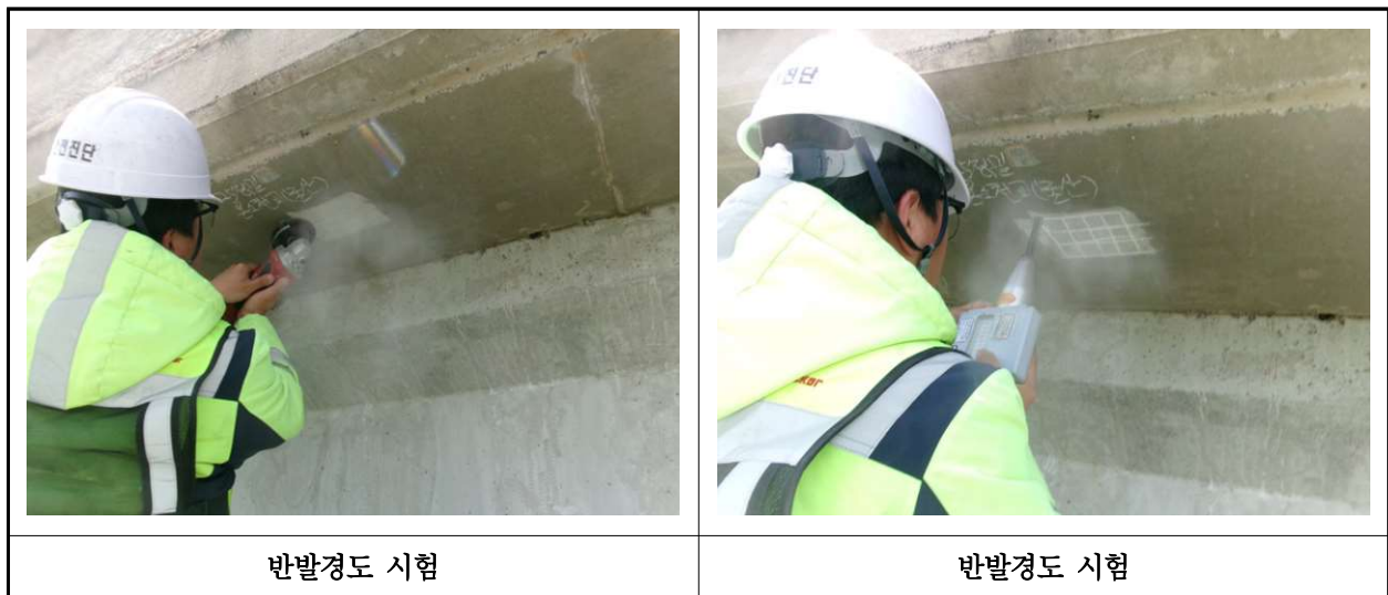
【사진 30.4.2】 반발경도시험 현장사진
