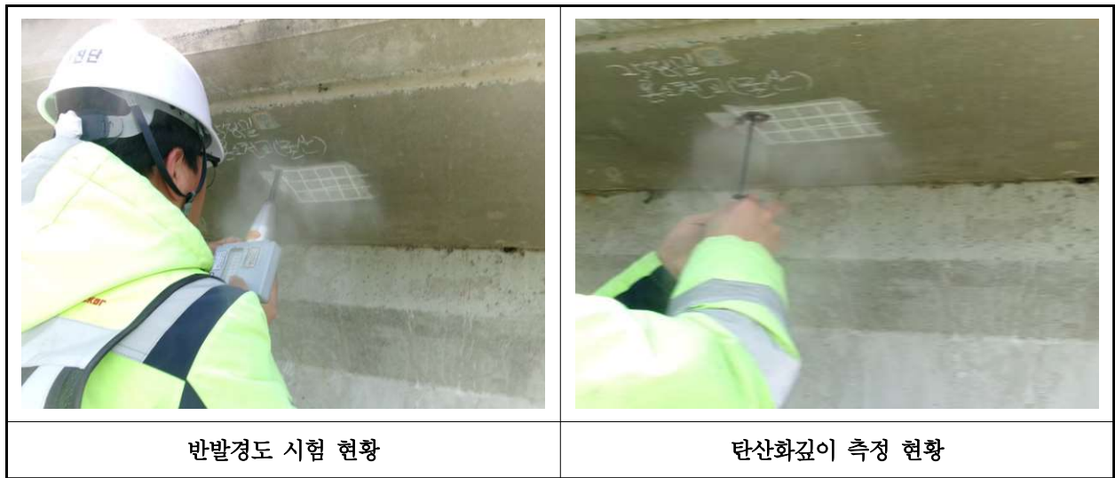
【사진 30.4.1】 콘크리트 내구성조사 현황
