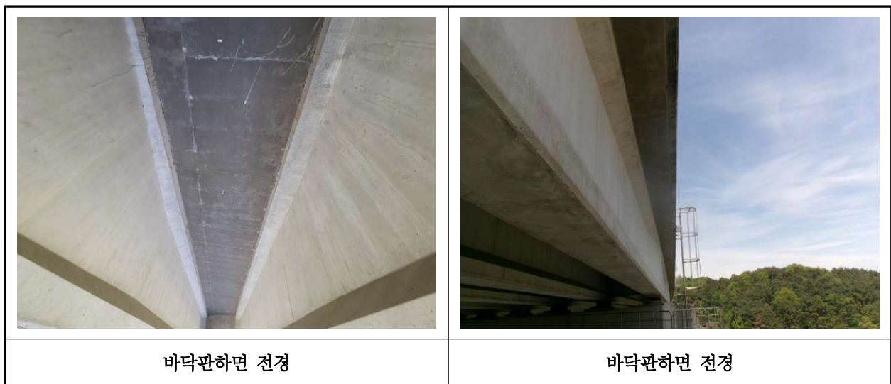
【사진 30.3.2】 바닥판하면 전경
